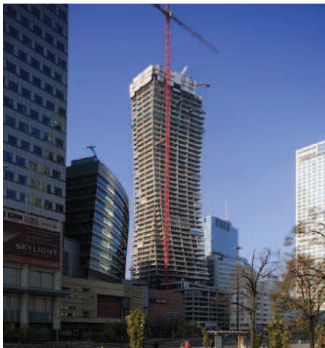
2012–2013. Residential Tower – Złota 44 w Warszawie.
