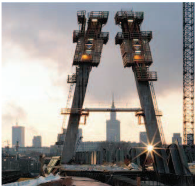
1999–2000. Pylon mostu Świętokrzyskiego w Warszawie.
