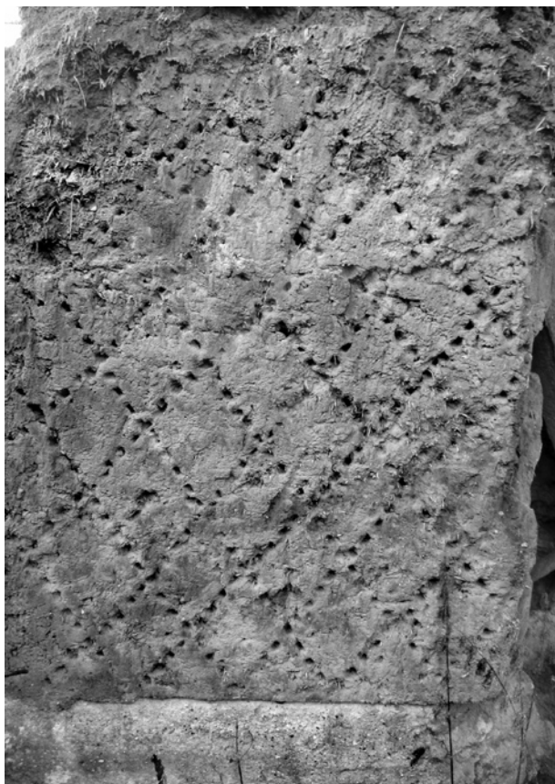
Ryc. 4. Ruiny budynku gospodarczego we wsi Aleksandrówka w gminie Szypliszki; fot. J. Lutyńska, 2015
