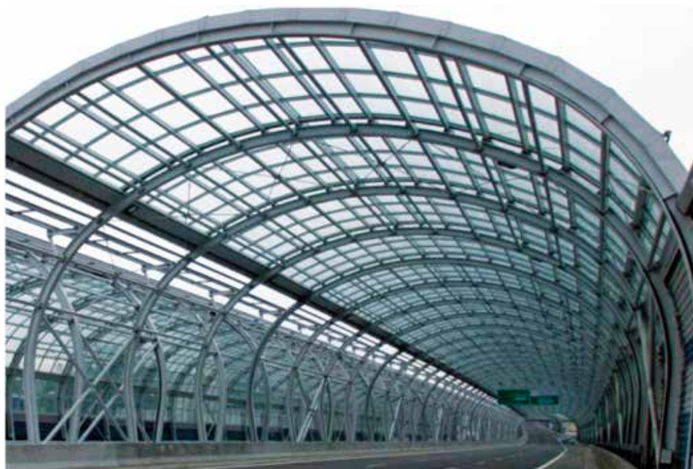
Fot. 5. Ekran akustyczny przy Trasie Toruńskiej w Warszawie (Źródło: http://warszawa.cz/forum/Watek-Drogowe-ekran-akustyczne-w-Warszawie )
