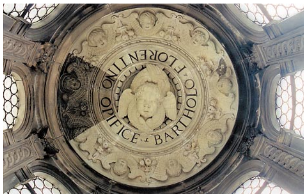
Kopułka latarni w trakcie czyszczenia metodą laserową
