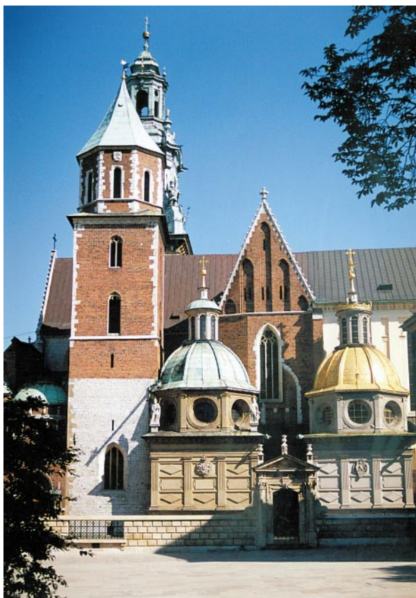
Widok kaplicy Zygmuntowskiej od strony zewnętrznej
