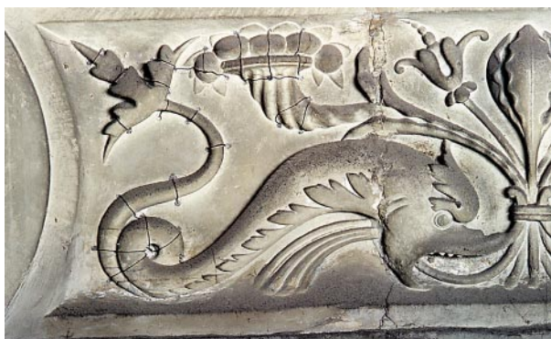
Listwa kopuły ze stworami morskimi. Zabrudzenie powierzchni i wzmocnienia z drutów srebrnych z lat pięćdziesiątych ubiegłego wieku
