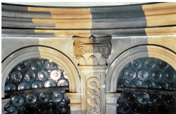
Fragment wnętrza latarni. Efekt czyszczenia powierzchni kamienia metodą laserową
