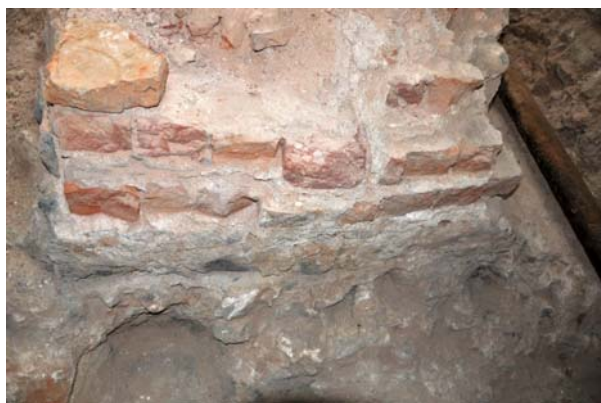
Ryc. 3. Fragmentarycznie zachowane lico zachodnie muru z zachowanym wewnętrznym poziomem użytkowym wnętrza, fot. Klaudia Stala
