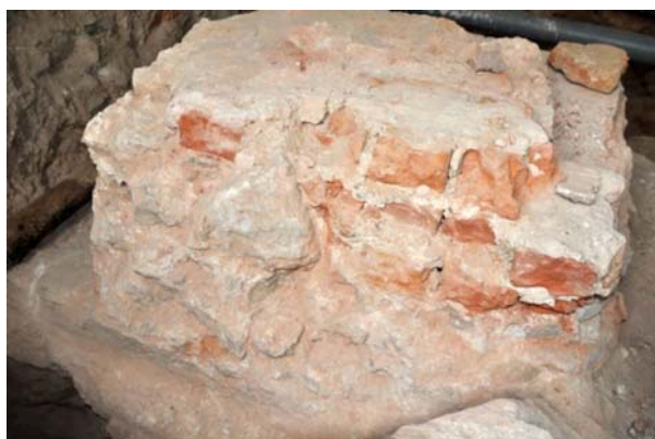
Ryc. 4. Fragmentarycznie zachowane lico wschodnie muru, fot. Klaudia Stala
