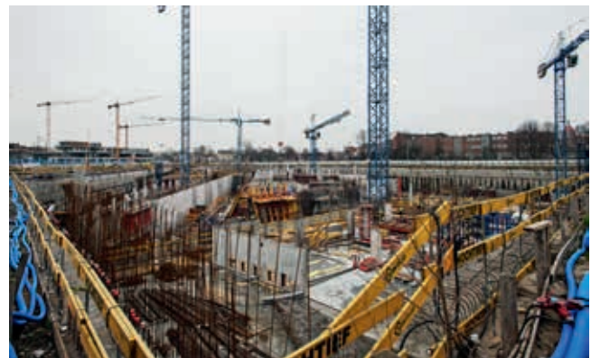
Szalowanie, zbrojenie i betonowanie ścian oraz stropów, marzec 2015 r., fot. R. Jocher
