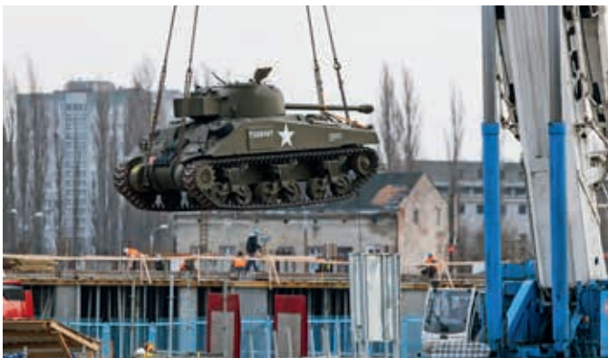
Czołg Sherman Firefly umieszczany na dnie wykopu, styczeń 2015 r., fot. R. Jocher
