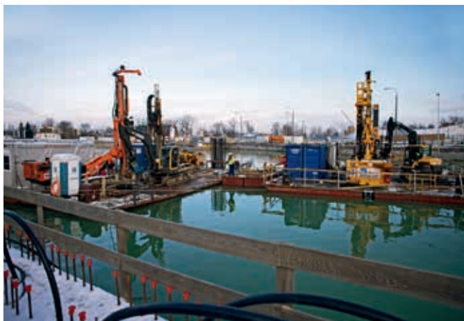
Wykonanie suchego wykopu: pogłębianie metodą refulacji i wylanie korka betonowego, fot. R. Jocher
