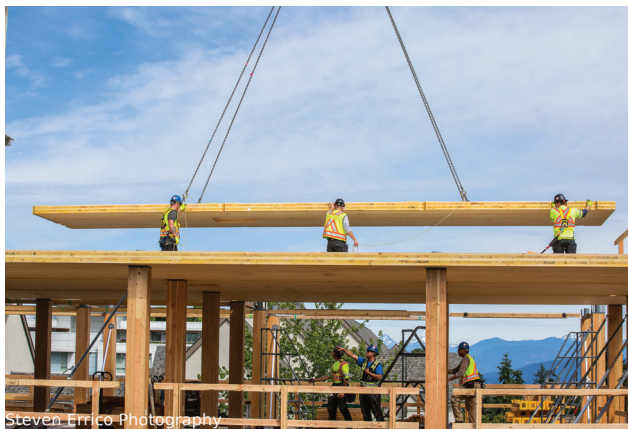
Zdjęcie 2. Prace budowlane przy użyciu prefabrykatów drewnianych w budynku Brock Commons [3]
