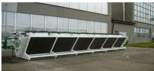
Rys.5. Chłodnia oleju grzewczego pras wulkanizacyjnych – stan przyszły
