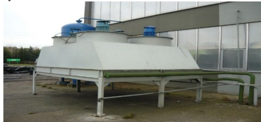
Rys.4. Chłodnia oleju grzewczego pras wulkanizacyjnych – stan obecny
