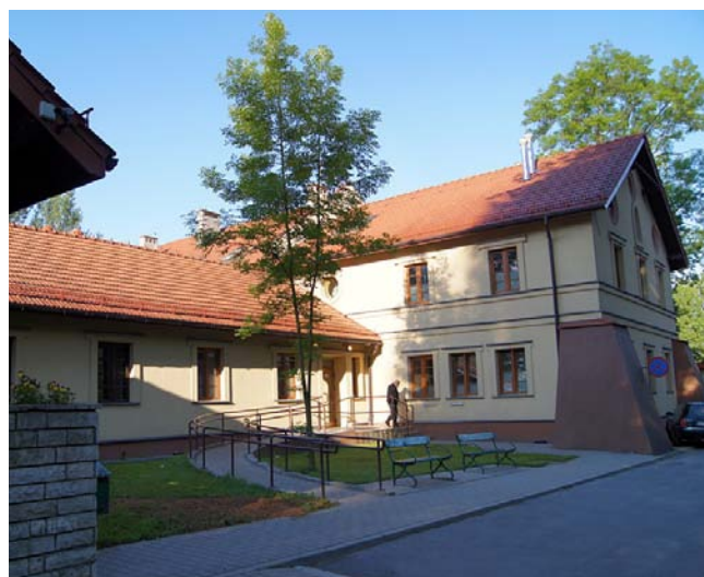
Fig. 1. The main Bath House in Swoszowice, phot. S. Jasińska • Główny Dom Zdrojowy w Swoszowicach, fot. S. Jasińska
