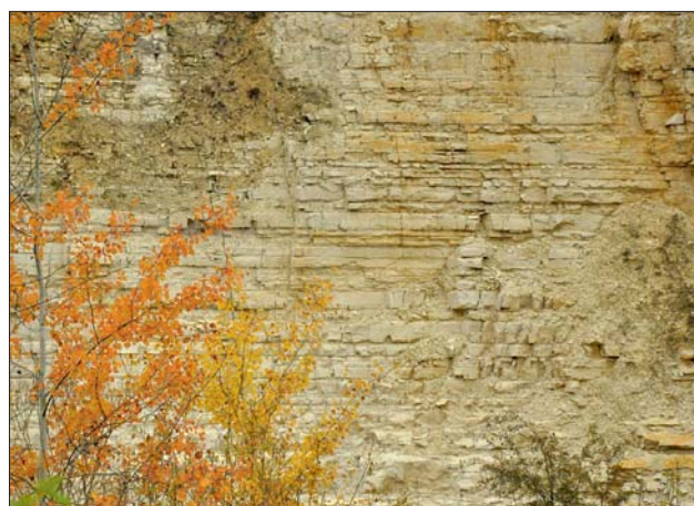
Ryc. 5. Wapienie uławiczone z przełwiczeniami margli w kamieniołomie Lipówka. Ryc. 4 i 5 fot. M. Krzeczyńska
