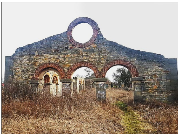
Ryc. 3. Walcownia huty żelaza w Nietulisku Dużym, widok ceglanych nadproży i dawnego naświetla, rok 2020; fot. M. Marchewka.
