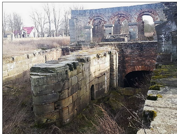
Ryc. 4. Walcownia huty żelaza w Nietulisku Dużym, rozprowadzenie zasilania wodnego do budynku walcowni z podziałem na dwa koryta zasilające, rok 2020; fot. M. Marchewka.
