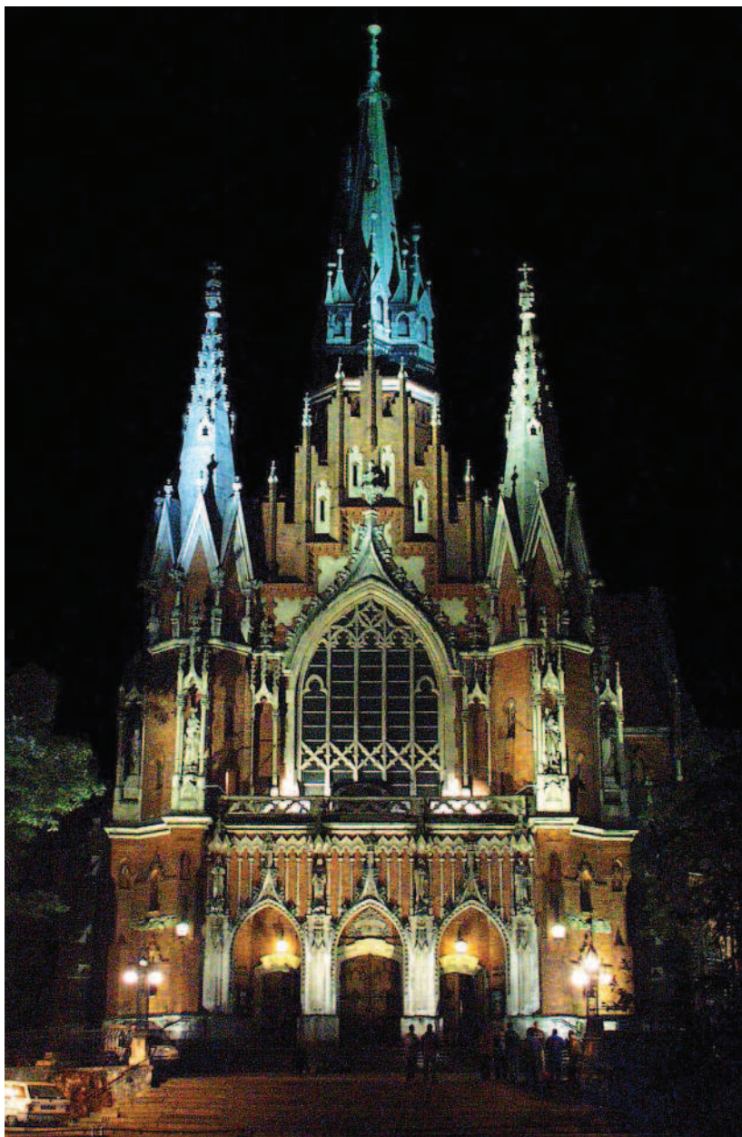
Prace przy iluminacji kościoła św. Józefa w Podgórzu. Fot. arch. Mirosław Sulma, 2003 r.
