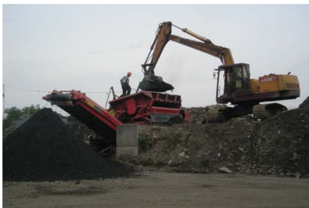
Ryc. 5. Sortowanie zanieczyszczonych gruntów na terenie budowy Oczyszczalni Ścieków Pomorzany w Szczecinie
