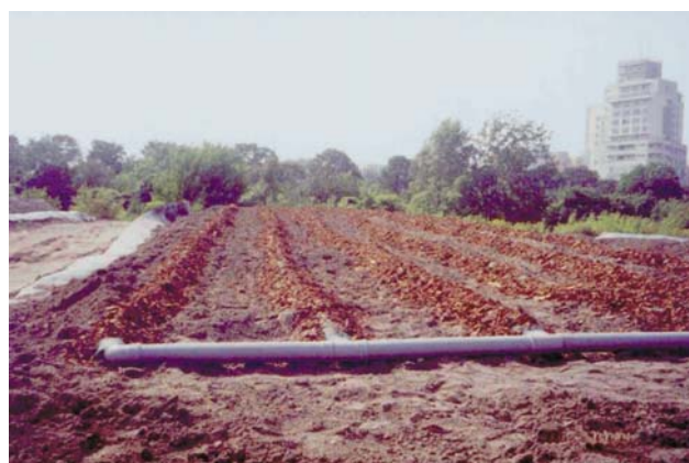
Ryc. 4. Budowa przyzmy rekultywacyjnej z gruntami zanieczyszczonymi związkami z grupy BTEX na obszarze dawnego Dworca Gdańskiego w Warszawie
