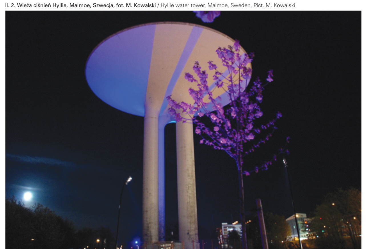
II. 2. Wieża ciśnieni Hyllie, Malmö, Szwecja, fot. M. Kowalski / Hyllie water tower, Malmö, Sweden, Pict. M. Kowalski
