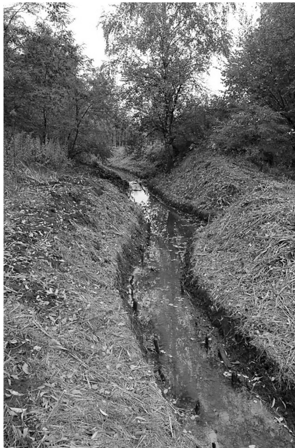
Rys. 8.3 Ciek wodny znajdujący się bezpośrednio w obrębie zwałowiska w Czerwionce-Leszczynach
