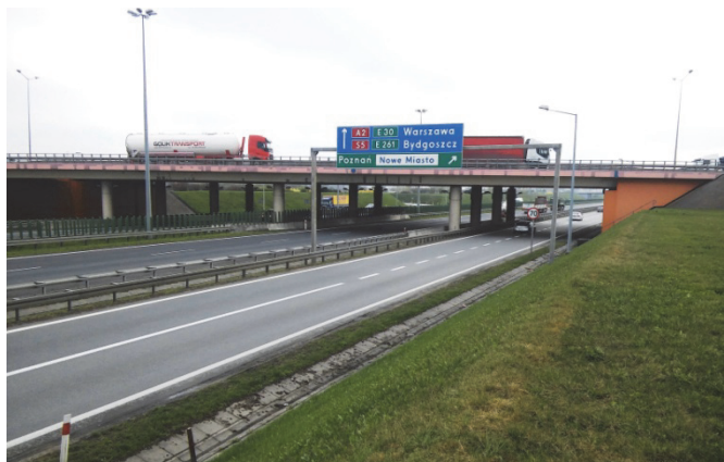
Rys. 2. Wiadukty WD-13 i WD-13a nad autostradą A2
