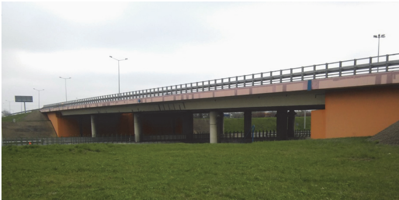
Rys. 4. Czteroprzęsłowa żelbetowa konstrukcja pomostów wiaduktów
