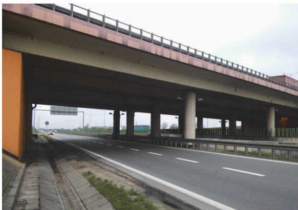
Rys. 7. Przyczółek uniemożliwia poszerzenie autostrady
