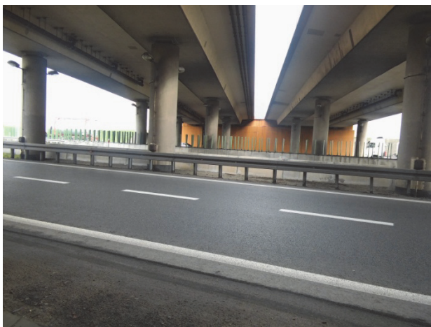
Rys.5. Podpory (filary i przyczółek) wiaduktów WD-13 i WD-13a
