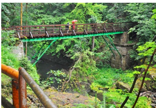
Stalowy mostek rozporowy w Hřensku (obiekt nr 46)
