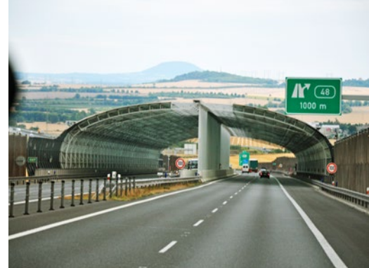
Krótki, żelbetowy tunel dwukomorowy na trasie Uście nad Łabą – Praga
