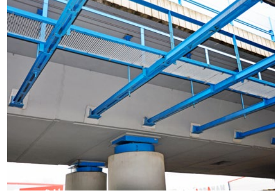
Estakada dojazdowa do obiektu nr 48 w Dečínie
