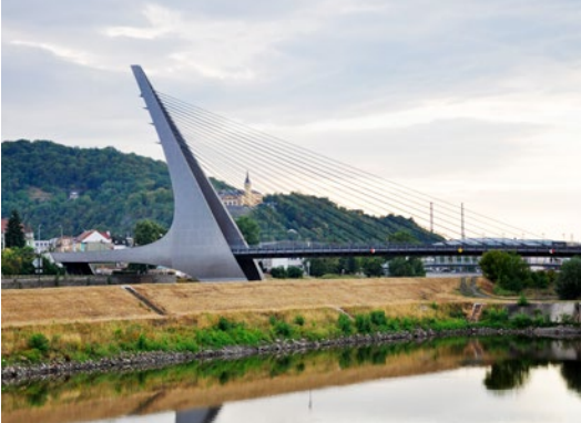
Jednopylonowy most podwieszony przez Łabę w Uściu nad Łabą (obiekt nr 49)
