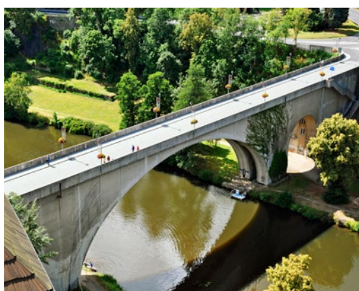
Żelbetowy most łukowy przez Ohrę w Loket (obiekt nr 45)
