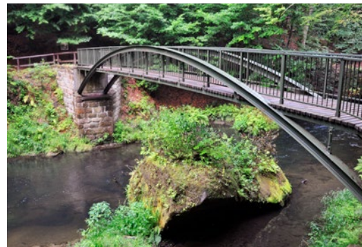
Stalowy mostek łukowy z pomostem pośrednim w Hřensku (obiekt nr 47)
