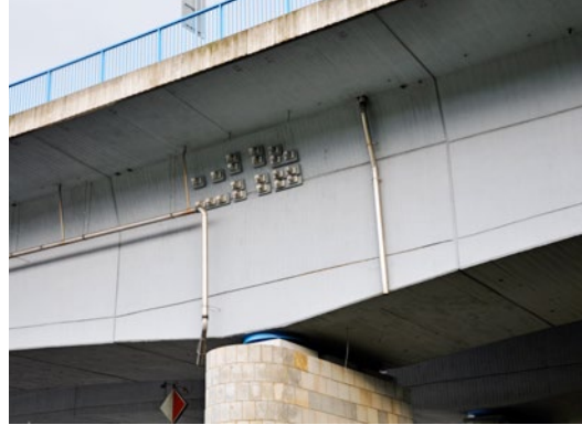
Sprężenie poprzecznicę podporowej obiektu nr 48 w Dečínie
