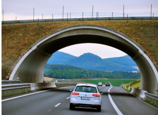
Krótki tunel z łupin żelbetowych na trasie Uście nad Łabą – Praga
