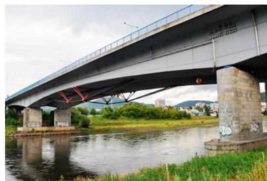
Betonowy most belkowy z dolnym podwieszeniem głównego przęsła w Dečínie (obiekt nr 48)
