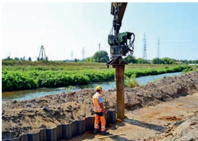
Ryc. 2. Modernizacja wałów przeciwpowodziowych na terenie Częstochowy
