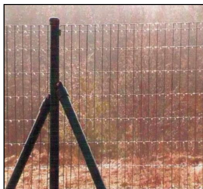
Rys. 1. Siatka zgrzewana sztywna zamocowana na słupku narożnym wspartym zastrzałami (zdjęcie autorskie)
