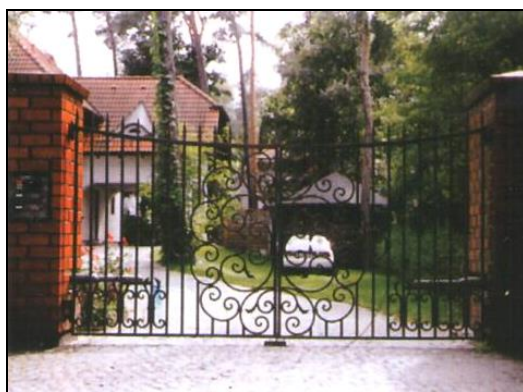
Rys. 4. Bramy kute osadzone w cegle klinkierowej (zdjęcie autorskie)
