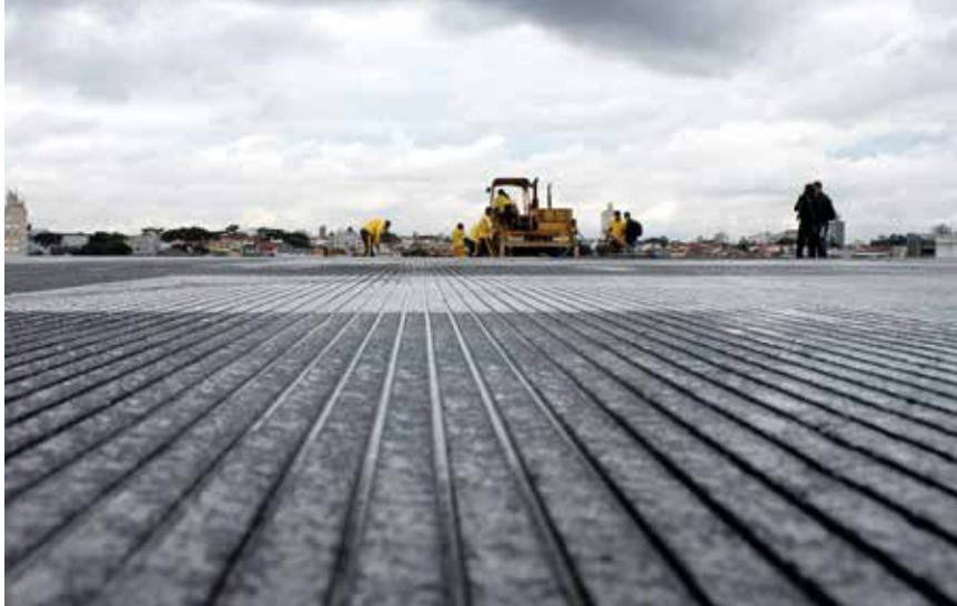
Rys. 7. Rowki i kanały w nawierzchni powstałe w wyniku rowkowania powierzchni betonu [źródło: www.nasa.gov]
