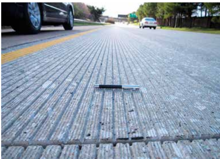
Rys. 8. Tekstura powierzchni uzyskana w wyniku połączenia zabiegu „grindingu” i rowkowania [źródło: www.igga.net]
