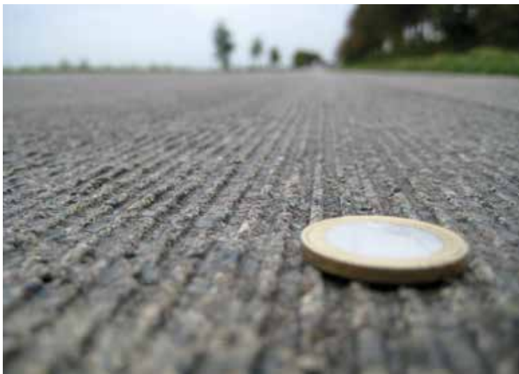
Rys. 6. Efekt mikrofrezowania na powierzchni betonu [źródło: www.bik-stroy.ru ]
