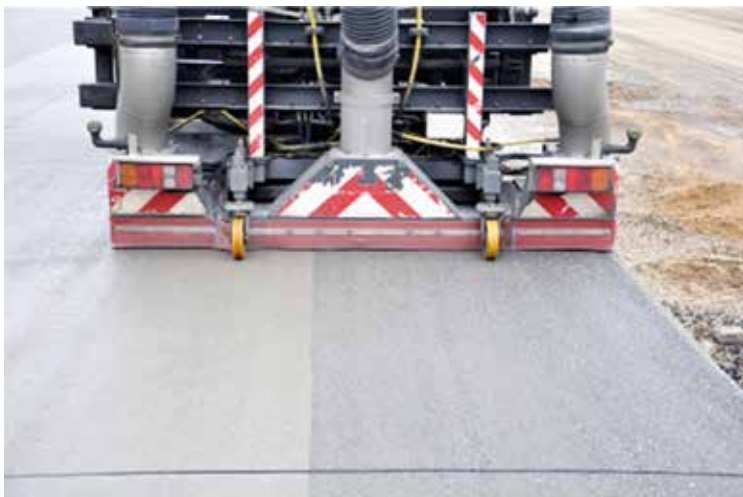
Rys. 5. Tekstura powierzchni uzyskana w wyniku działania wody pod ciśnieniem [źródło: Archiwum TPA]
