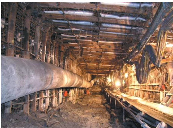
Rys. 23. Rozcinka ścianowa zabezpieczona obudową ŁPro/A
