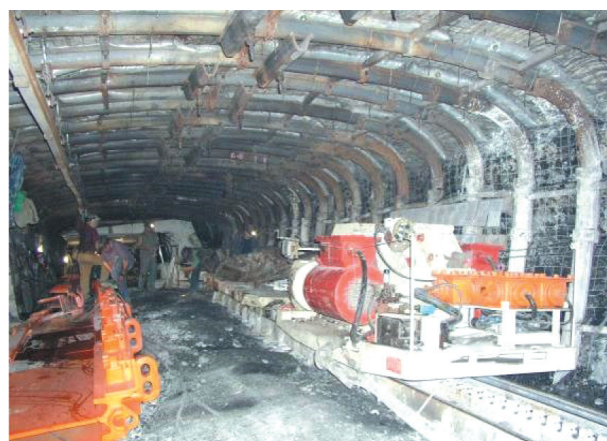
Rys. 42. Zbrojenie ściany w rozcince ścianowej zabezpieczonej obudową ŁPrP, wykonanie K
