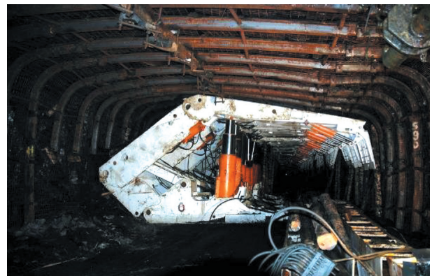
Rys. 48. Zbrojenie ściany, przecinka zabezpieczona obudową ŁPrw
