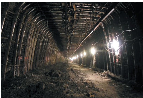
Rys. 39. Rozcinka ścianowa zabezpieczona obudową ŁPrP, wykonanie Ł
