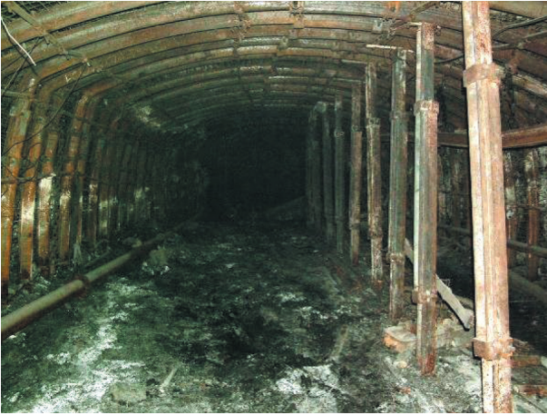
Rys. 33. Rozcinka ścianowa zabezpieczona odrzwiami ŁPrP czteroelementowymi
