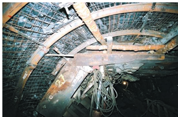
Rys. 7. Zbrojenie ściany, rozcinka wykonana w odrzwiach kojarzonych ŁPK
