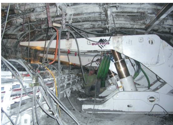
Rys. 41. Zbrojenie ściany w rozcince ścianowej zabezpieczonej obudową ŁPrP, wykonanie K
