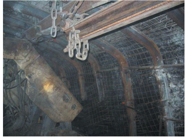
Rys. 34. Zbrojenie ściany, rozcinka zabezpieczona odrzwiami ŁPrP czteroelementowymi
