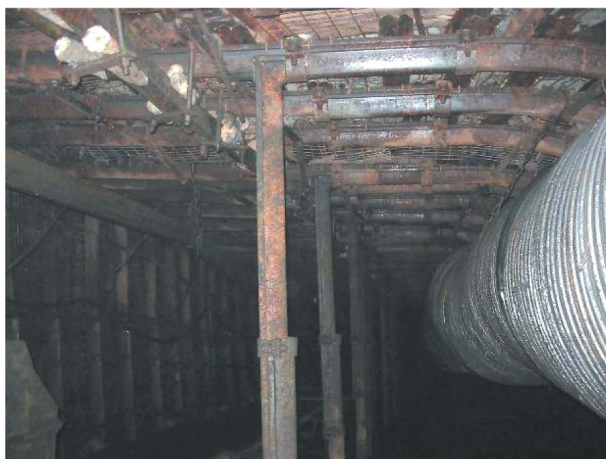
Rys. 19. Rozcinka rozruchowa zabezpieczona obudową ŁPro/B
