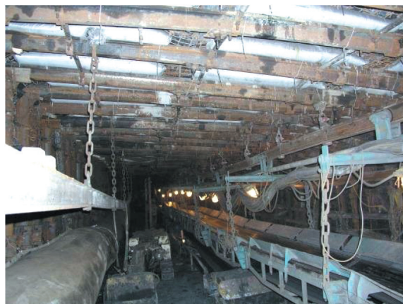
Rys. 24. Rozcinka ścianowa zabezpieczona obudową ŁPro/A
