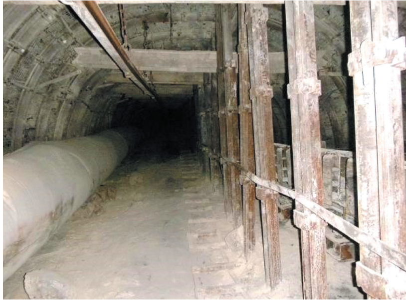
Rys. 16. Rozcinka zabezpieczona obudową ŁPKO
