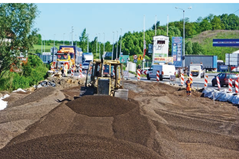
Ryc. 6. Przykład zastosowania jako górnej warstwy zasyпки lekkiego kruszywa jednofrakcyjnego w postaci keramzytu w trudnych warunkach geotechnicznych podłoża rodzimego
