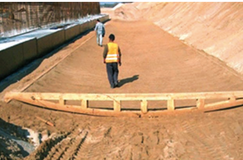
Ryc. 5. Przykładowy widok wyprofilowanego fundamentu kruszywowego pod przepust o konstrukcji gruntowo-powłokowej
