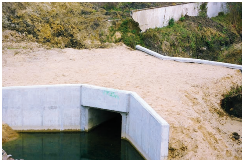
Ryc. 9. Przykładowy przepust o konstrukcji betonowej ze skrzydłami ukośnymi z wykonaną zasypką piaskową
