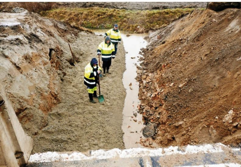
Ryc. 4. Przykład wykonywania warstwy chudego betonu pod konstrukcją przepustu (w niezabezpieczonym wykopie)
