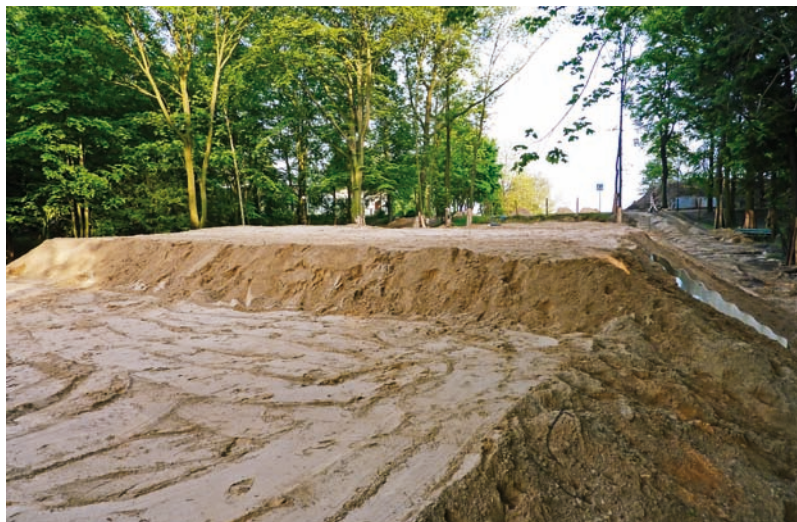
Ryc. 8. Kolejna faza wykonywania zasyпки w górnej jej części dla konstrukcji przepustu pokazanego na rycinie 7
