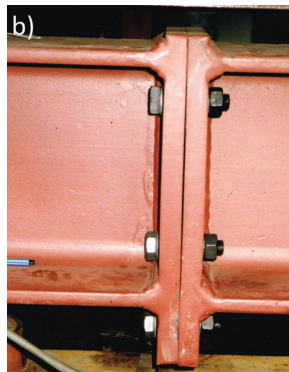
Fot. 1. Typowe doczołowe połączenia na śruby sprężające: a) rygla ze słupem ramy hali stalowej, b) dwóch belek dwuteowych
