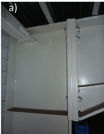
Fot. 1. Typowe doczołowe połączenia na śruby sprężające: a) rygla ze słupem ramy hali stalowej, b) dwóch belek dwuteowych
