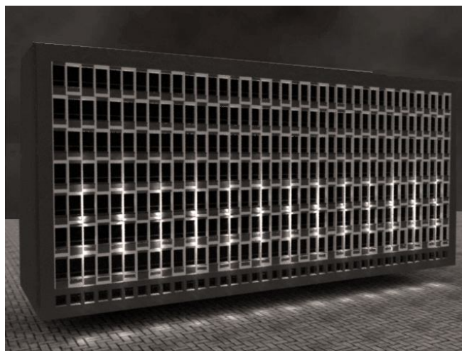
Rys. 3. Wizualizacja komputerowa iluminacji Collegium Novum przy użyciu kinkietów wąskostrumieniowych, montowanych bezpośrednio na elewacji
