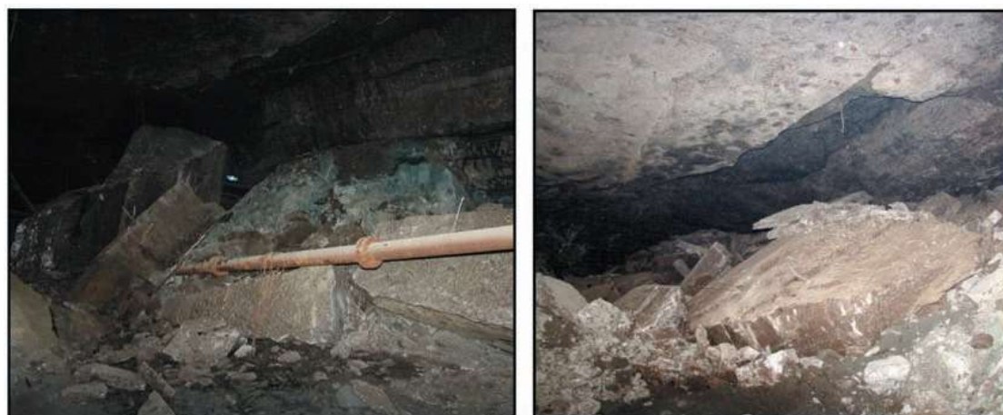
Rys. 2. Przykłady obwałów stropu w wyrobiskach chodnikowych Fig. 2. Examples of rock fall in the underground excavations
