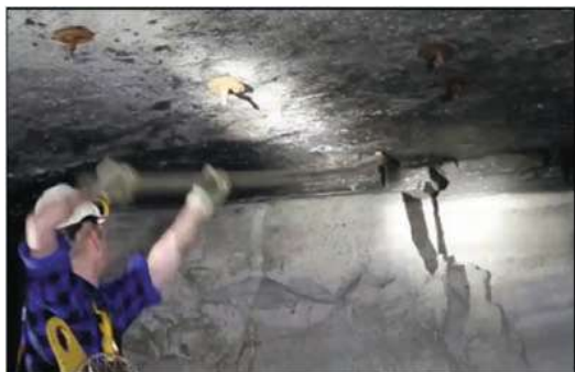
Rys. 3. Obrywka ręczna wykonywana przez pracownika (Źródło: KGHM Polska Miedź S.A.)
