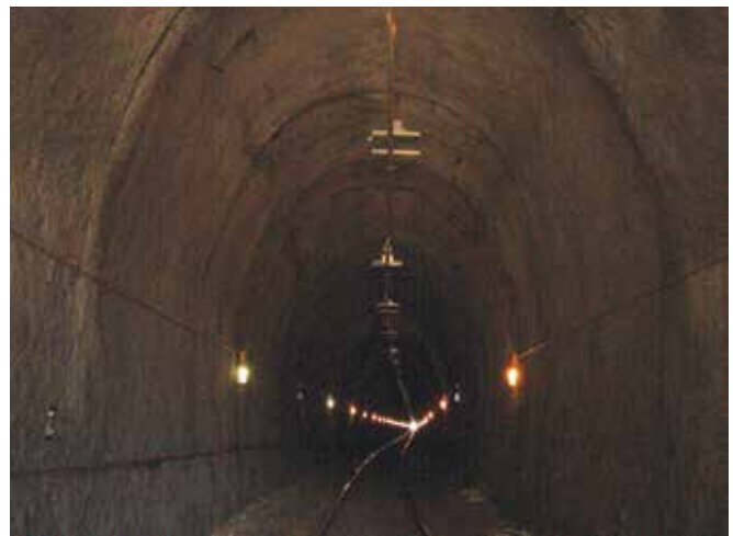
Fot. 4. Widok tunelu z siecią sztywną z fot. 1. Fot. W. Majewski
