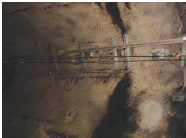
Fot. 2. Strefa przejściowa sieć łańcuchowa-sieć sztywna, widok „od dołu” wlotu z fot. 1. Fot. W. Majewski
