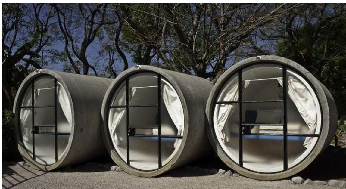
Rys. 3.1 Kapsuły mieszkalne z rur kanalizacyjnych w Tepoztlan koło Mexico City
