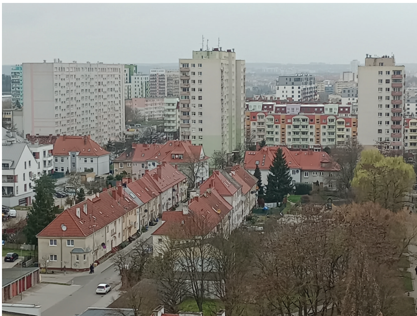
Fot. 3. Tradycyjne budownictwo. Budynki murowane o drewnianej konstrukcji dachu
