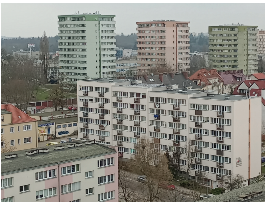
Fot. 4. Technologia wielkiej płyty. Budynki 5-, 6- i 12-kondygnacyjne
