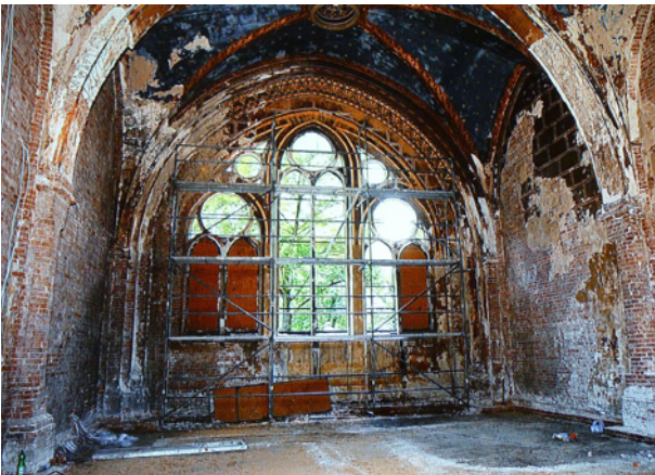
Ryc. 9. Sala ceremonialna przed renowacją; źródło: Muzeum Miejskie w Gliwicach Fig. 9. Ceremonial hall before renovation; source: Municipal Museum in Gliwice
