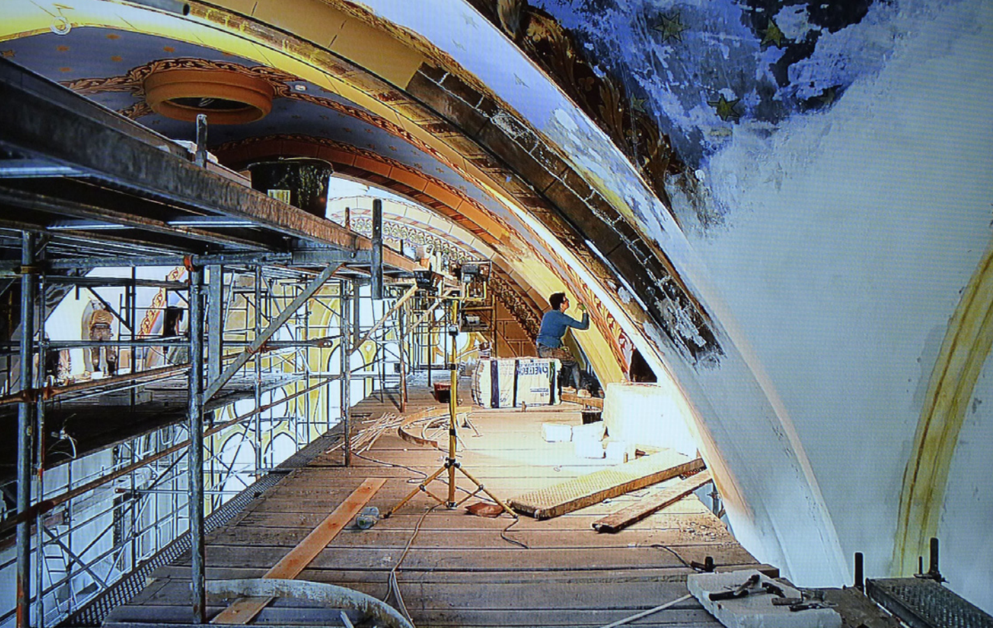
Ryc. 6. Renowacja polichromii, źródło: Muzeum Miejskie w Gliwicach Fig. 6. Renovation of polychromes; source: Municipal Museum in Gliwice
