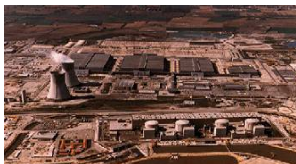
Fot. 3. Zakład wzbogacania uranu (ZWU) metodą dyfuzji gazowej w Tricastin we Francji (należący do EDF) – zamknięty w 2012 r. [32]
