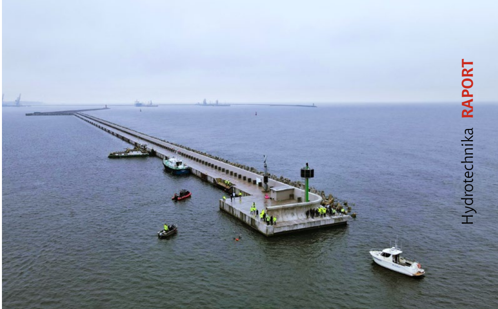
Modernizacja falochronów Portu Północnego w Porcie Gdańsk, fot. A. Małkiewicz, Urząd Morski w Gdyni
