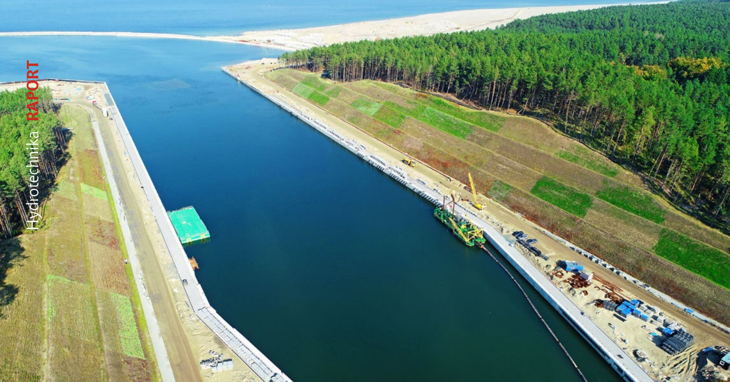
Przekop Mierzei Wiślanej, fot. NDI i BESIX
