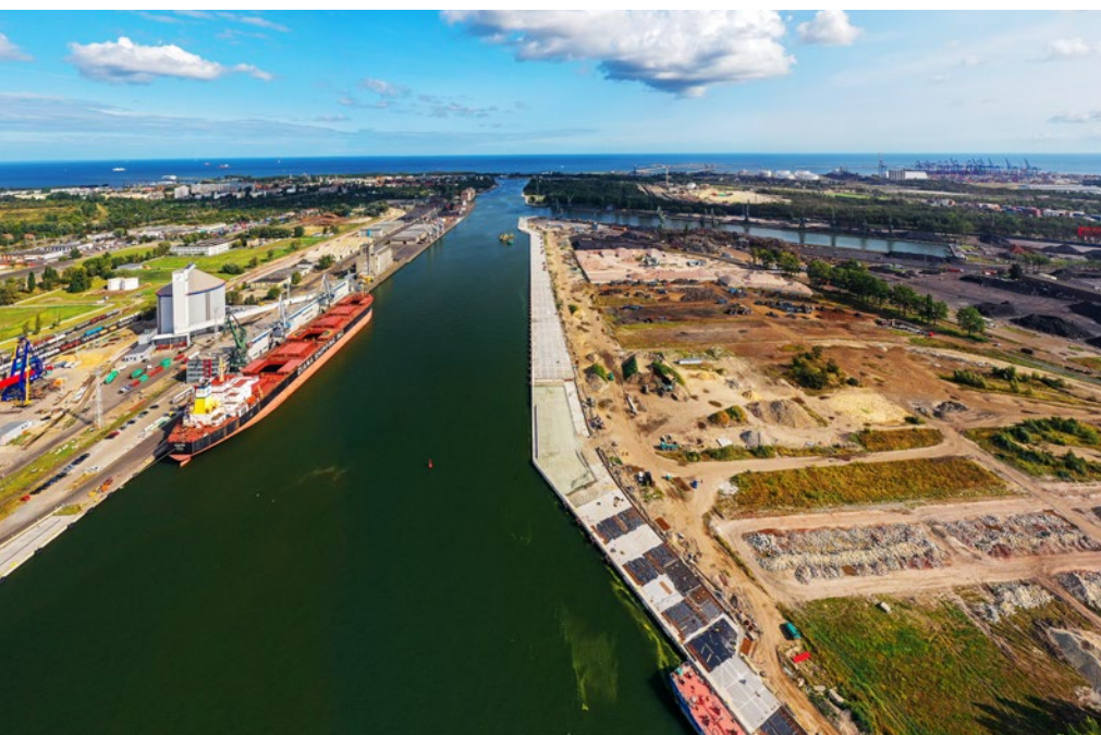
Modernizacja nabrzeża Dworzec Drzewny w Porcie Gdańsk, fot. Port Gdańsk SA
