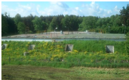
Rys.3.3.Reaktor biologiczny SBR 5.1 i SBR 5.2 [6]
