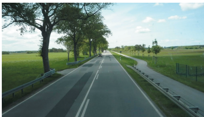
Rys. 12. Usytuowanie drogi dla pieszych wzdłuż drogi zamiejskiej lub ulicy poza barierą bezpieczeństwa i poza rowem
