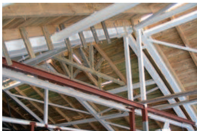
Rys. 8. Stalowo-drewniana konstrukcja dachu zastosowana przy adaptacji przestrzeni dachowej zabytkowego budynku (fot. A. Żaboklicki)
