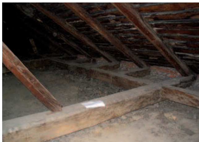
Rys. 13. Wiązanie jętkowe o dużej rozpiętości dachu kamienicy z II połowy XIX wieku w Kielcach. Wiązary pełne oparte zostały na belkach wiązarskich, a wiązary puste opierane są na podstopkach zamocowanych w przejściach (fot. A. Żaboklicki)
