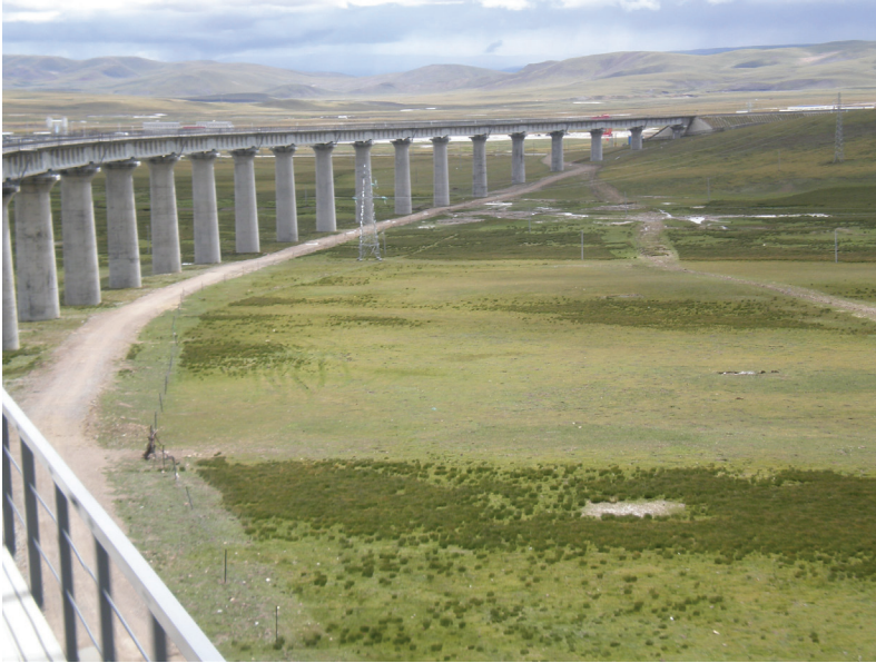
Rys. 6. Estakada na linii dużych prędkości Wubang – Guangzhou w Chinach (fot. A. Massel)
