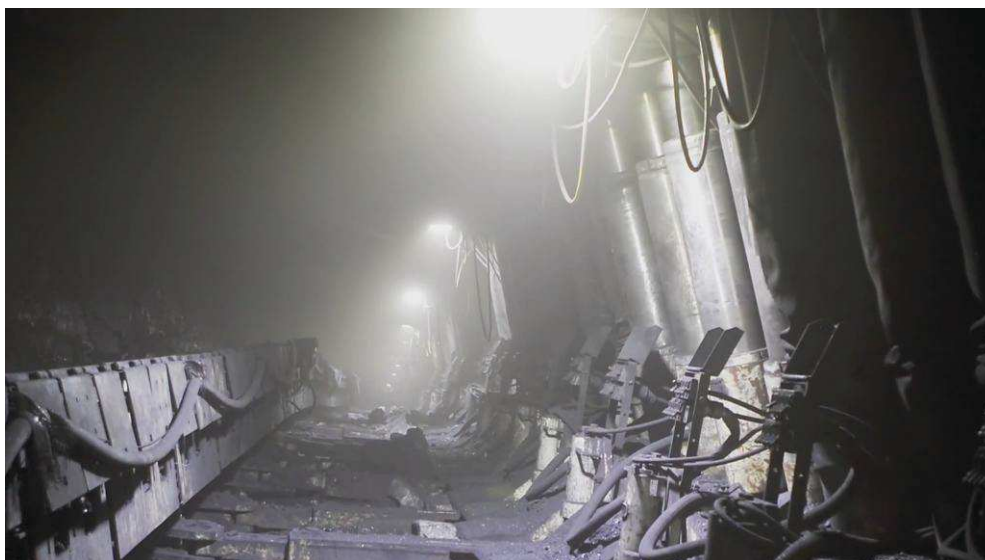
Rys. 18. Ściana 152 w trakcie eksploatacji [2]
