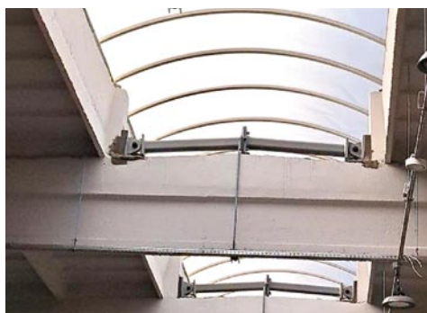
Rys. 7. Przykładowy widok zrealizowanego wzmocnienia
