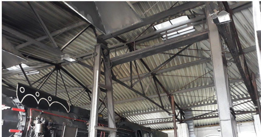
Rys. 3. Widok stalowej konstrukcji dachu parowozowni
