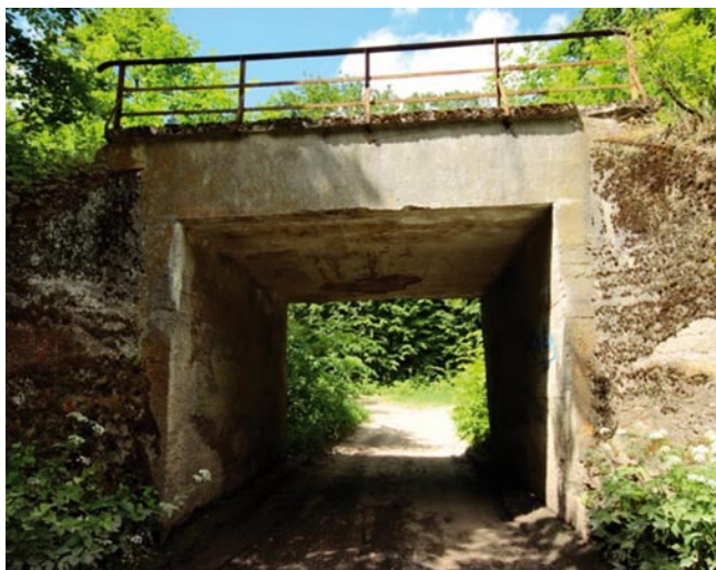
Rys. 1. Widok mostu od strony południowo-wschodniej; stan na czerwiec 2017 r. (źródło: autor)
