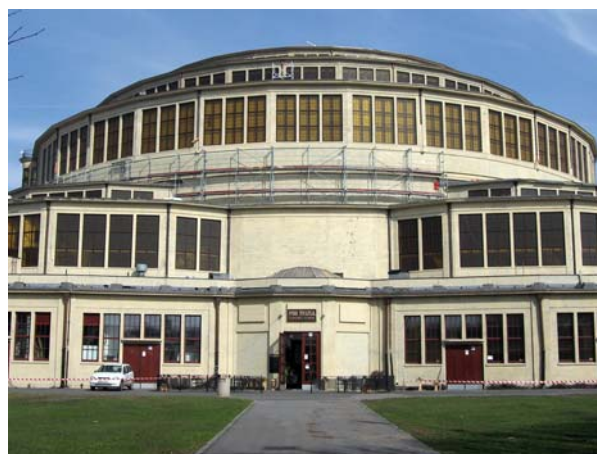
Ryc. 4. Elewacje frontowa i południowo-zachodnia po remoncie (fot. M. Goleń, R. Dzugaj)
