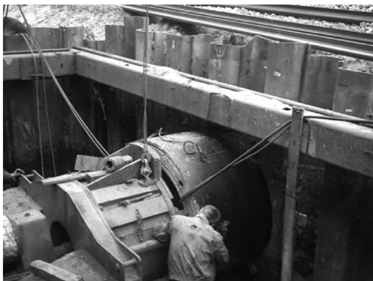
Rys. 2. Budowa przepustu metodą przecisku po całkowitym zakończeniu robót torowych (fot. udostępniona przez Jerzego Zalewskiego)
