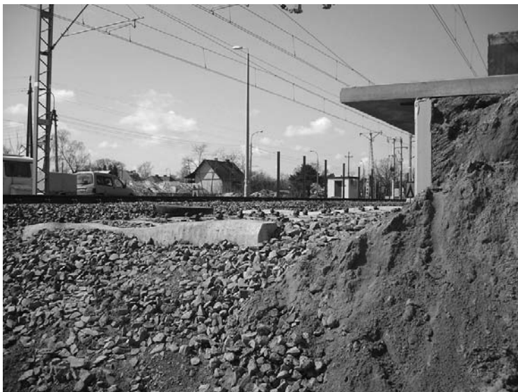
Rys. 1. Rozpoczęcie robót fundamentowych po ukończeniu robót w nawierzchni i podtorzu
