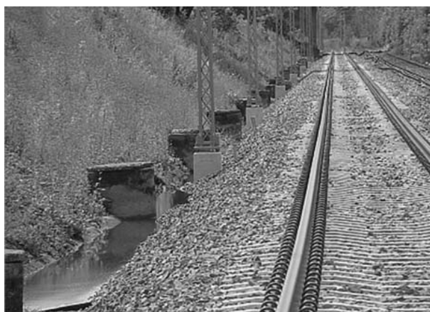
Rys. 3. Nowy tor, lawy torowiska do krawędzi podsypki pokrywa woda (fot. ze zbiorów IK)
