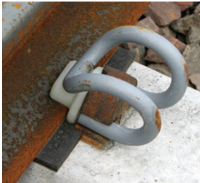
Rys. 3. Ilustracja zasady klasyfikacji systemów przytwierdzeń szyn z uwagi na kryterium połączenia szyny z podporą szynową - bezpośrednio przytwierdzenie szyn:
