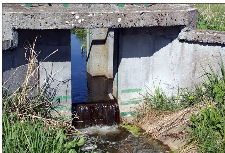
Fot. 2. Zastawka piętrząca wodę w dobrym stanie technicznym na obiekcie Supraśl Dolna (fot. A. Kiryluk) Phot. 2. The weir damming in n technical practicability on the Supraśl Dolna object (phot. A. Kiryluk)
