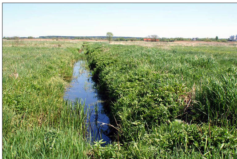
Fot. 1. Zarośnięty i zamulony rów melioracyjny na obiekcie Supraśl Dolna (fot. A. Kiryluk) Phot. 1. Overgrown and slimed meliorated ditch on the Supraśl Dolna object (phot. A. Kiryluk)
