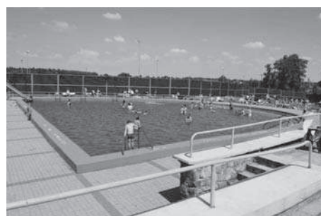
Rys. 5. Trzeci z analizowanych basenów kąpielowych (NIE 109.3)
