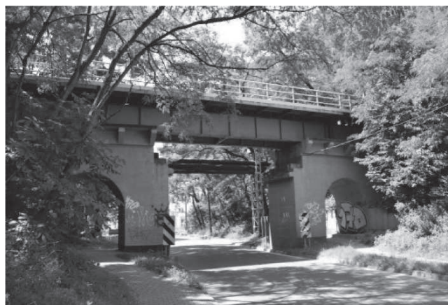
Rys. 2. Widok wiaduktu kolejowego nad ul. Wilsona w Knurowie. W tabelicy 1 zestawiono dane opisujące konstrukcję wiaduktu kolejowego nad ul. Niepodległości
