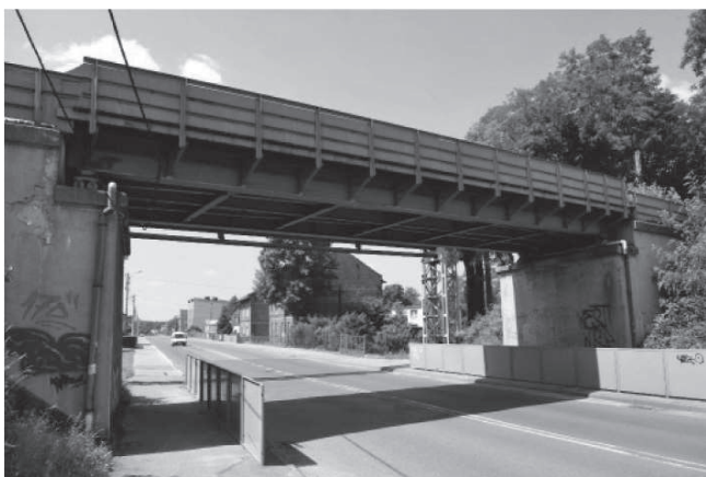
Rys. 1. Widok wiaduktu kolejowego nad ul. Niepodległości w Knurowie.
