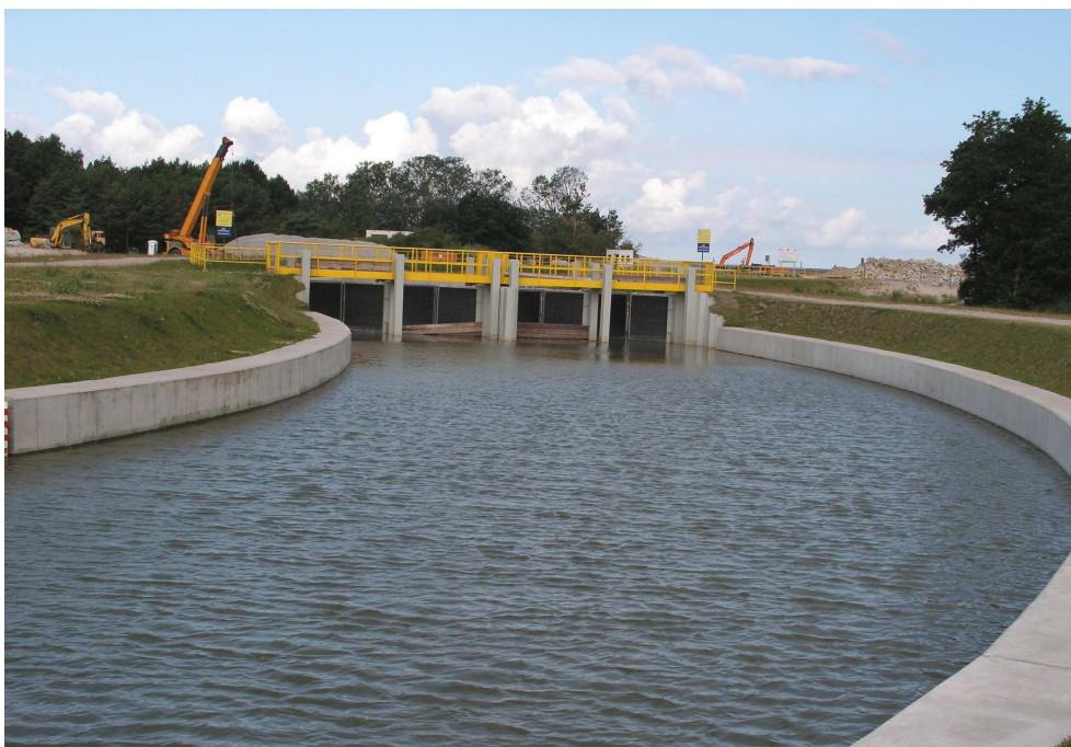
Rys. 3. Wrota przeciwsztormowe na Kanale Jamneńskim
