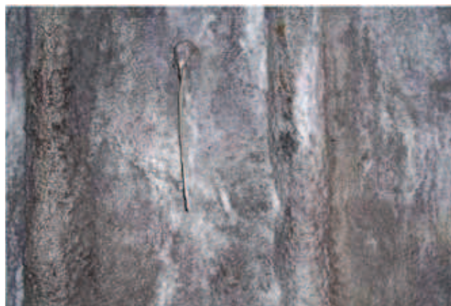
Rys. 7. Powłoka – torkret TSM 70 Fig. 7. Coating – gunita TSM 70
