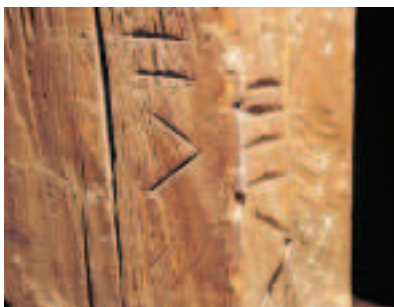
Ryc. 11. Stolec z podwójną numeracją Fig. 11. Queen post with double numbering
