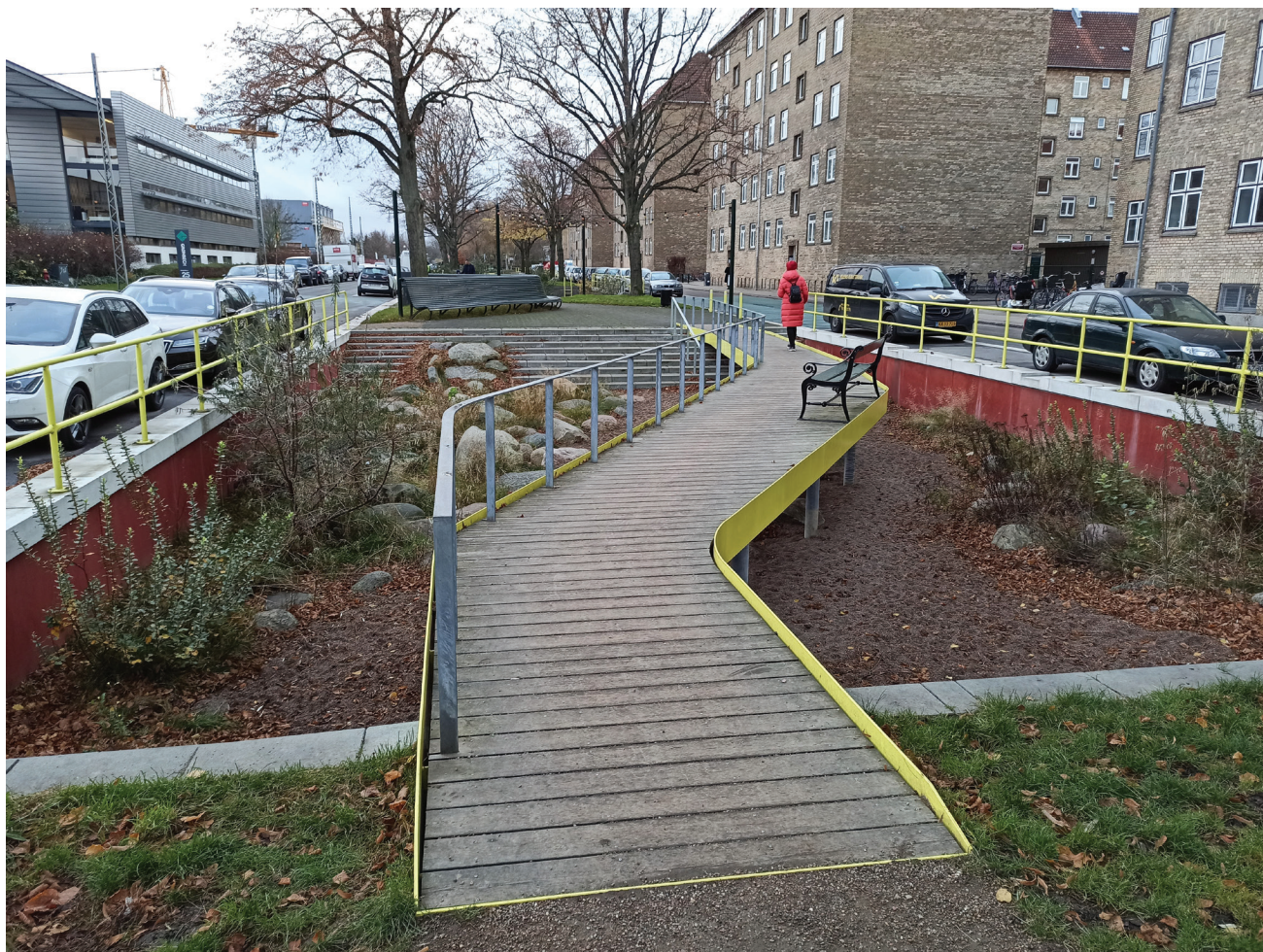
Fot. 2. Ulica gromadząca wodę – Scandiagade, Kopenhaga; źródło: fot. autor, 24.11.2021
