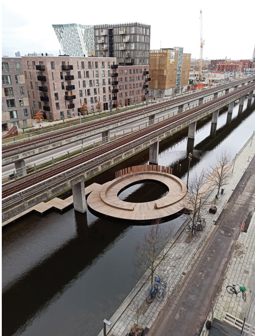
Fot. 1. Kanał gromadzący wodę pomiędzy ulicami, pod linią metra, dzielnica Ørestad, Kopenhaga; źródło: fot. autor, 24.11.2021
