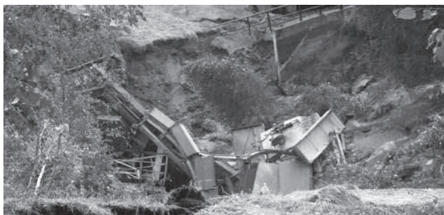
Rys. 4. Lej zapadliskowy w miejscu katastrofy szybu V KWK „Szczygłowice” w 2008 r.
