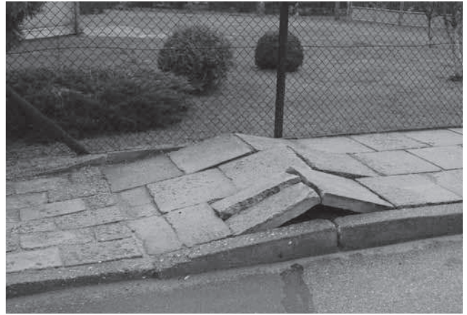
Rys. 12. Nieciągła forma deformacji obiektów powierzchniowych w postaci garbu w chodniku o szerokości przekraczającej 20 cm
