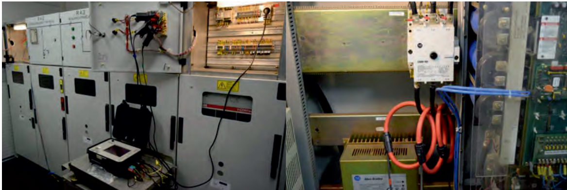
Fig. 4. Measurement of bucket wheel drive Fig. 4. Pomiar napędu koła czerpakowego
